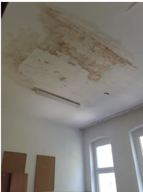
Fot.4. Pomieszczenia po dawnej szkole - Pomieszczenie nr 1/28
