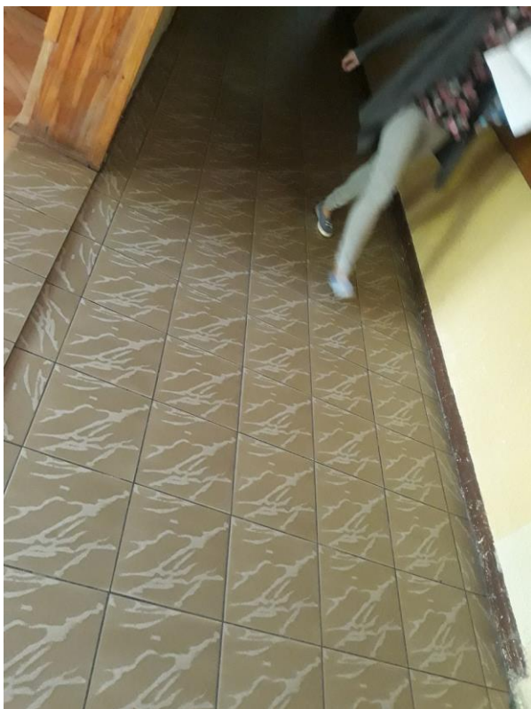
Fot.4. Korytarz – Pomieszczenie nr 0/10.
