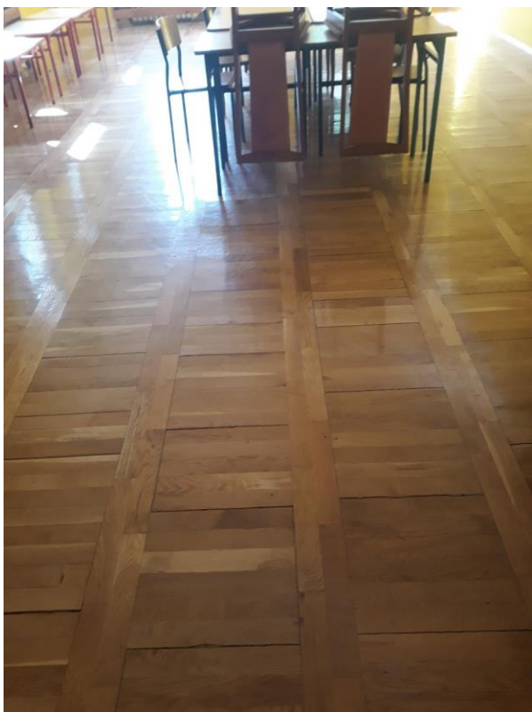
Fot.6. Pomieszczenie nr 1/8.
