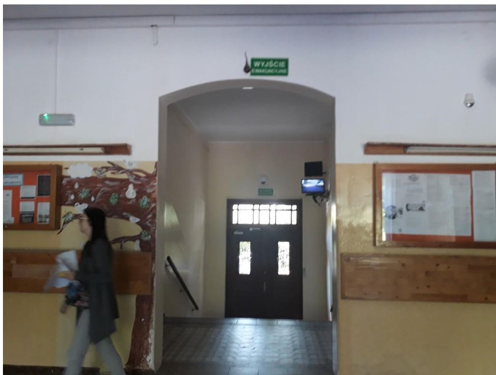
Fot.2. Hall wejściowy – pom. 0/10. Otwór do osadzenia drzwi przesuwnych
