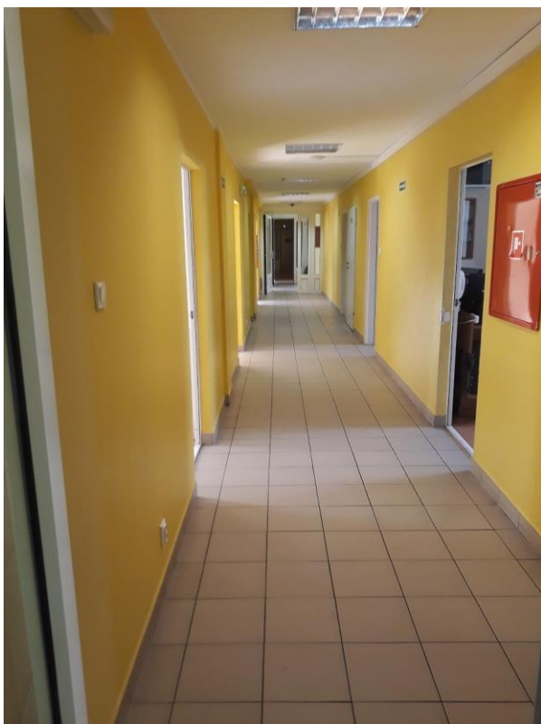
Fot.1. Korytarz komunikacyjny- Pomieszczenie nr 2/16
