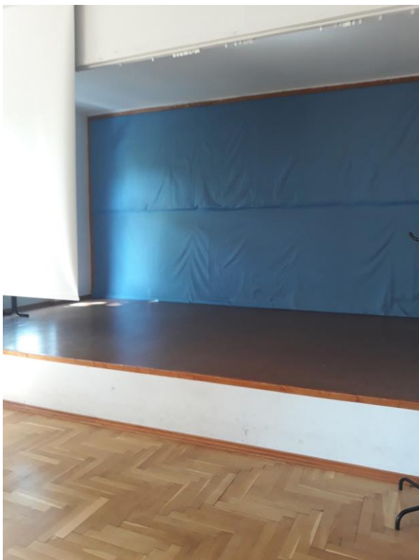
Fot. 7. Scena do demontażu - Pomieszczenie nr 1/18
