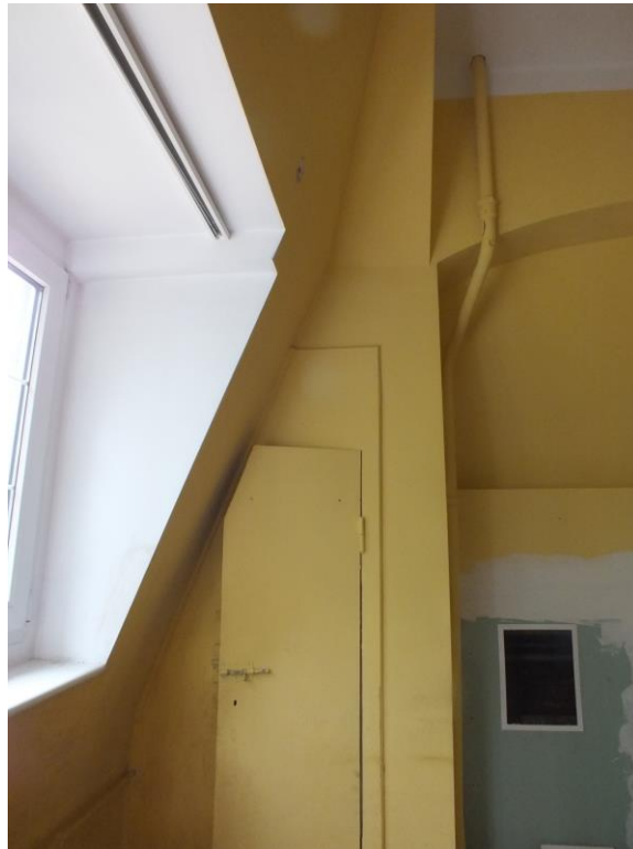
Fot. 8 c. Ósme usprawienie: Docieplenie szaf i wnęk wbudowanych (pom. 2.16)
