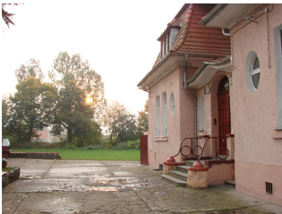
Fot. 2. Czwarte, piąte usprawnienie: rekonstrukcja drzwi wejściowych i docieplenie ścian piwnic, wykonanie izolacji pionowej i poziomej ścian piwnic.
