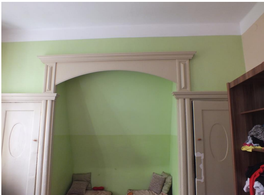
Fot. 8 a. Ósme usprawnienie: Docieplenie szaf i wnęk wbudowanych (pom. 2.11)
