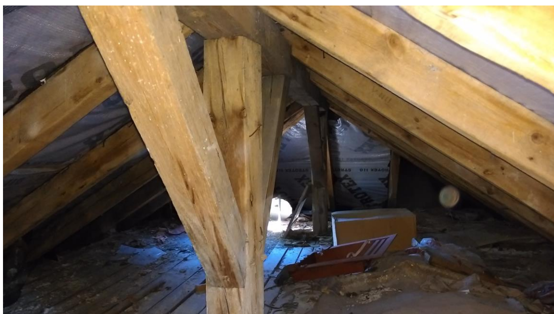
Fot. 11. Jedenaste i dwunaste usprawienie: Docieplenie podłogi i stropu nieużytkowego poddasza
