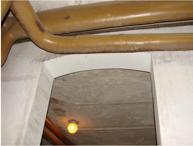
Fot. 14. Czternaste usprawnienie: Modernizacja instalacji c.w.u.: wycięcie starych przewodów położenie nowych, wymiana zbiornika c.w.u., wymiana grzejników.
