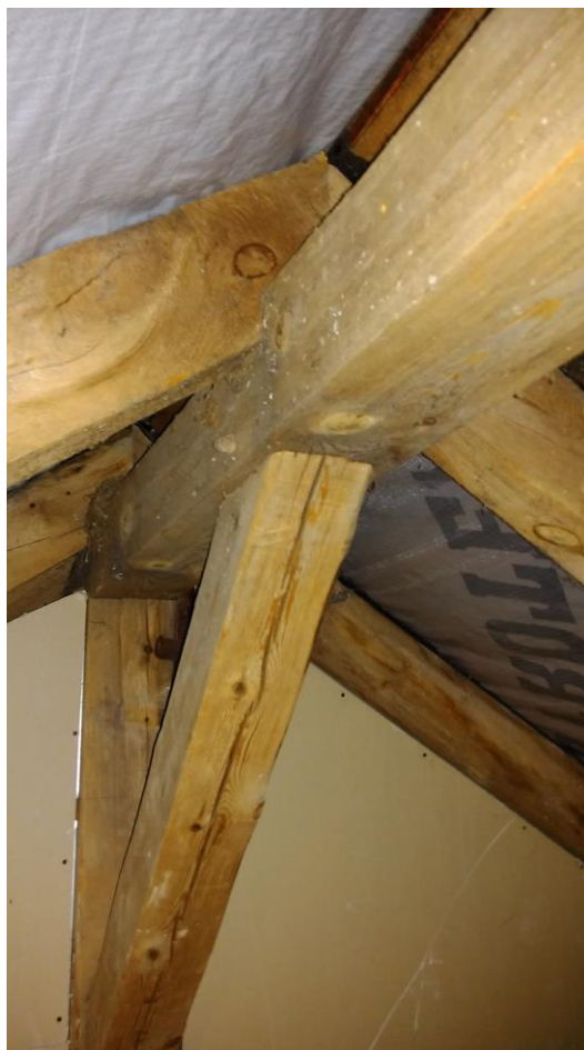
Fot. 10. Dziesiąte usprawienie: Docieplenie części połaci dachu stromego
